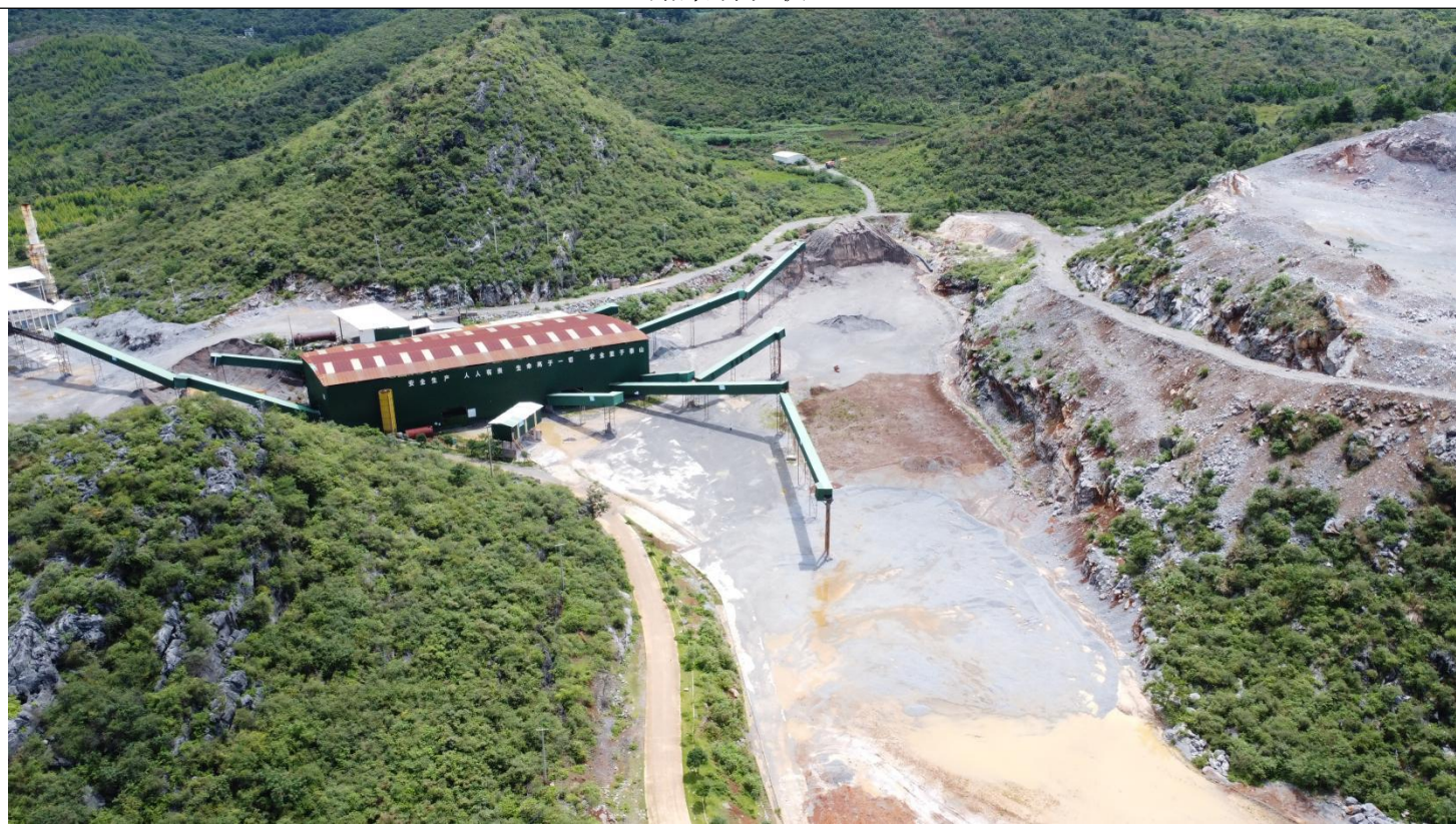
工业广场现状
