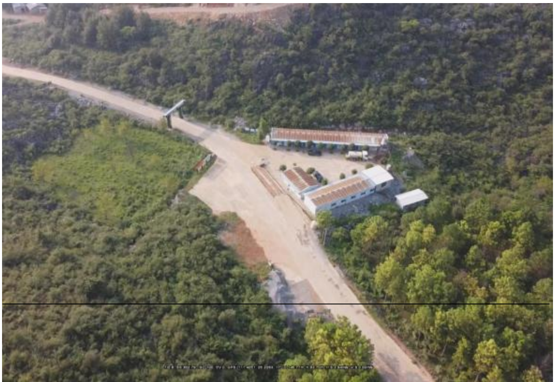
插图 3-3 矿山的矿部全貌
