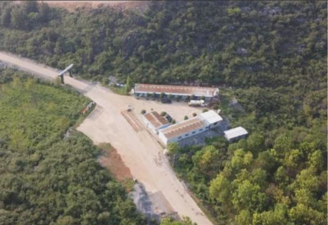
办公生活区现状
