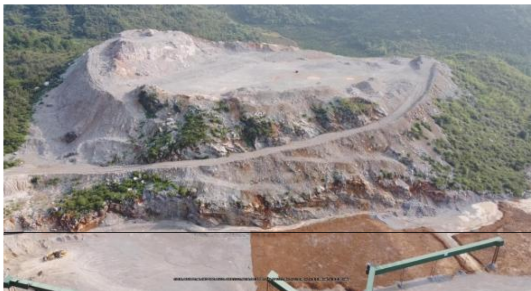
插图3-1 现状露采场全貌
