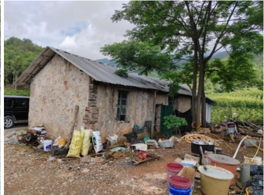
图2-4 村民临时搭建临时杂物棚
